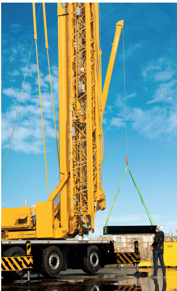
Zusätzlicher Kranarm zum Positionieren der Stahlplatten.
